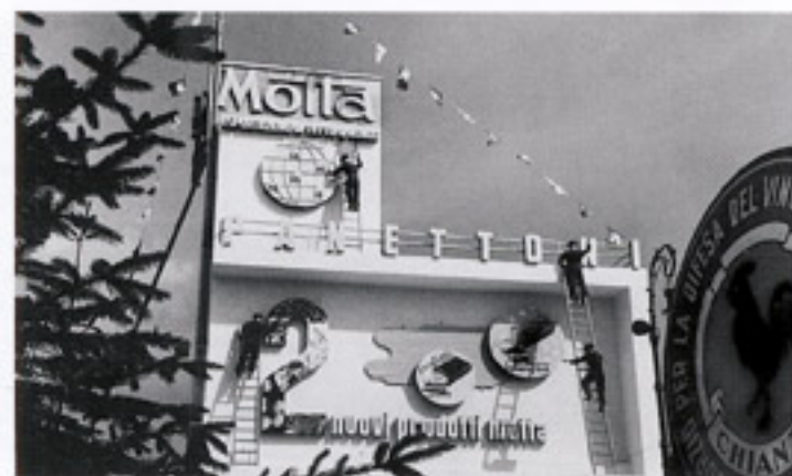
Allestimento del padiglione della Motta alla Fiera Campionaria di Milano, 1937
