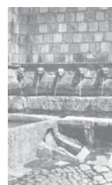
17. L'Aquila Particolare della Fontana delle 99 cannelle in Piazza San Vito
