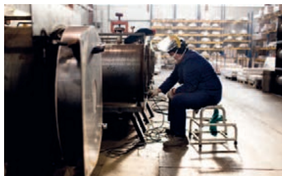
ICI Caldaie S.p.A., Zevio (VR)
