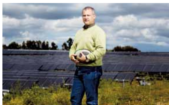
Centrale fotovoltaica Montalto di Castro, Viterbo.
